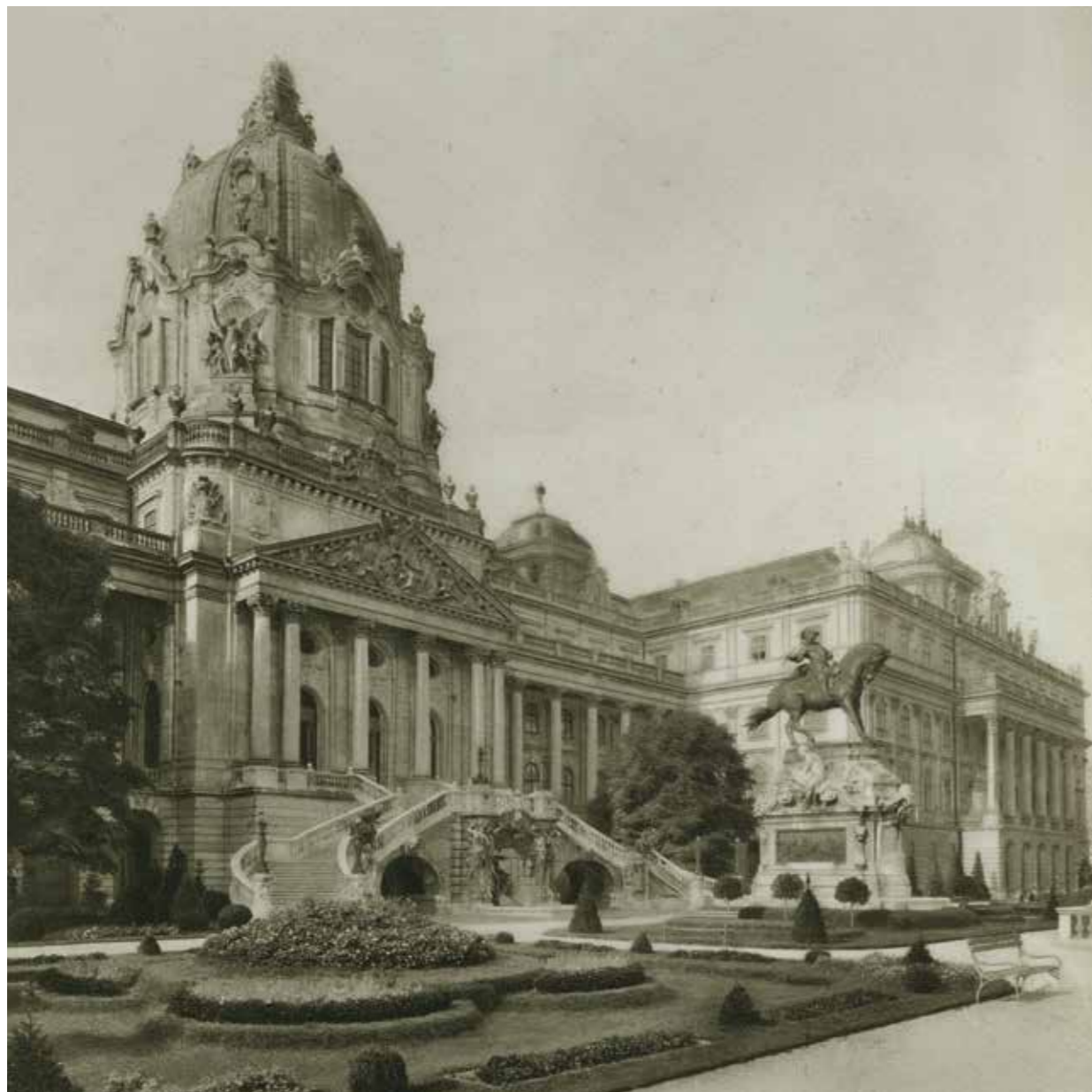
A palota új dunai szárnya a kupolával és a teraszra vezető Habsburg-lépcsővel, 1912 körül (Magyar Építészeti Múzeum és Műemlékvédelmi Dokumentációs Központ)
