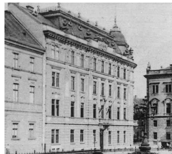
Az épület nyugati homlokzata, 1904
