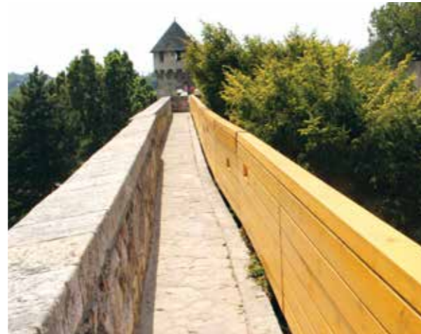
Déli gyilokjáró a felújítás után
